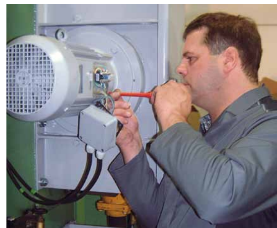
Montaż wysokowydajnej turbiny AGTOS .
