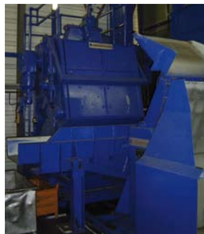
...und nachher mit neuem Schallschutz, diversen Reparaturen und neuer Lackierung.
